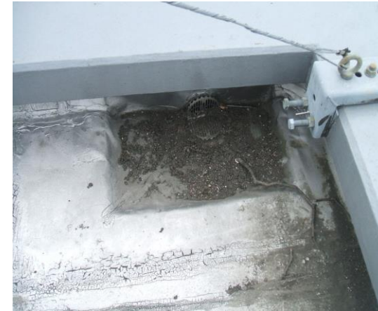
写真は屋上の排水ドレン：土砂の堆積
